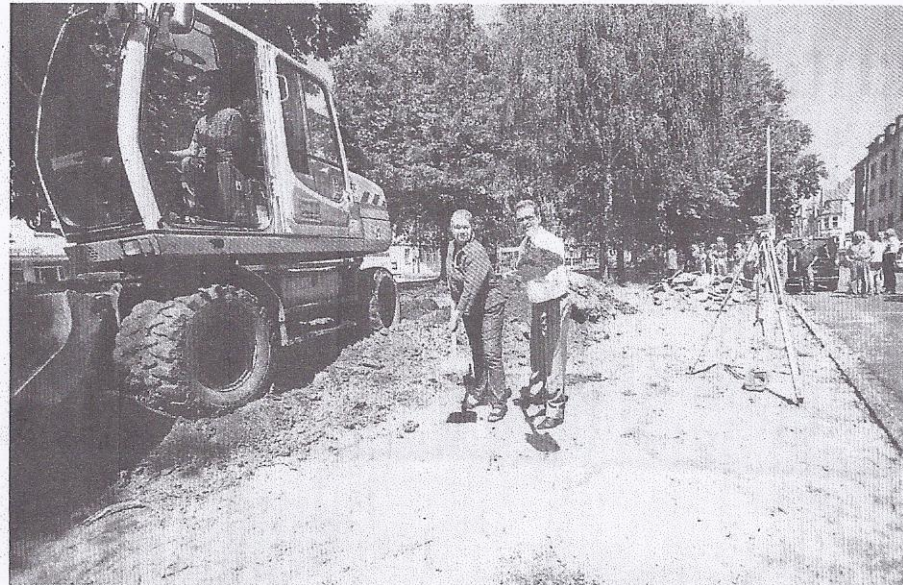
Carla Kaiser von der Bürgergemeinschaft Bismarckviertel und Oberbürgermeister Gregor Kathstede gestern beim offiziellen Spatenstich auf dem Bismarckplatz. Links räumt der Bagger schon die Fläche frei. RP-FOTOS (2), THOMAS LAMMERTZ
